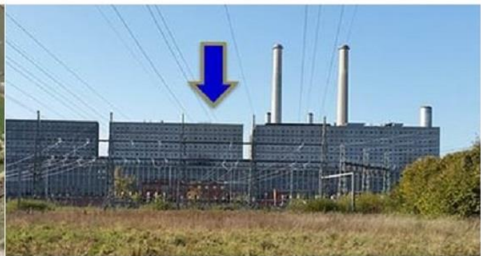
Dit is het aanzicht van de centrale voordat het slooproject van start ging. De pijl merkeert de plaats waar de nu geplande werkzaamheden plaatsvinden.
