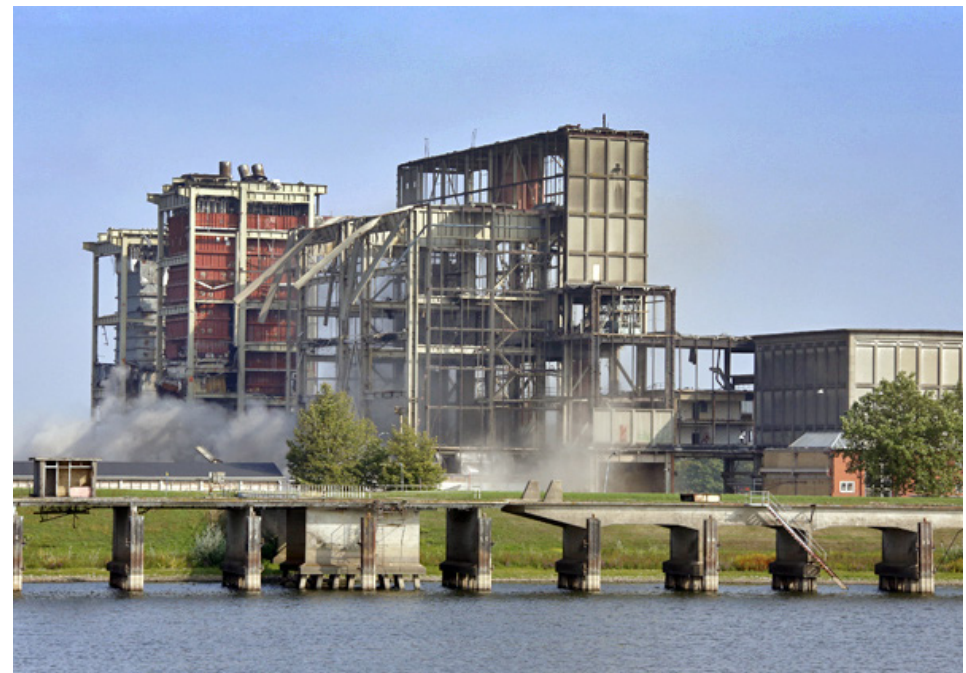
Ontmantelen van de IJsselcentrale
