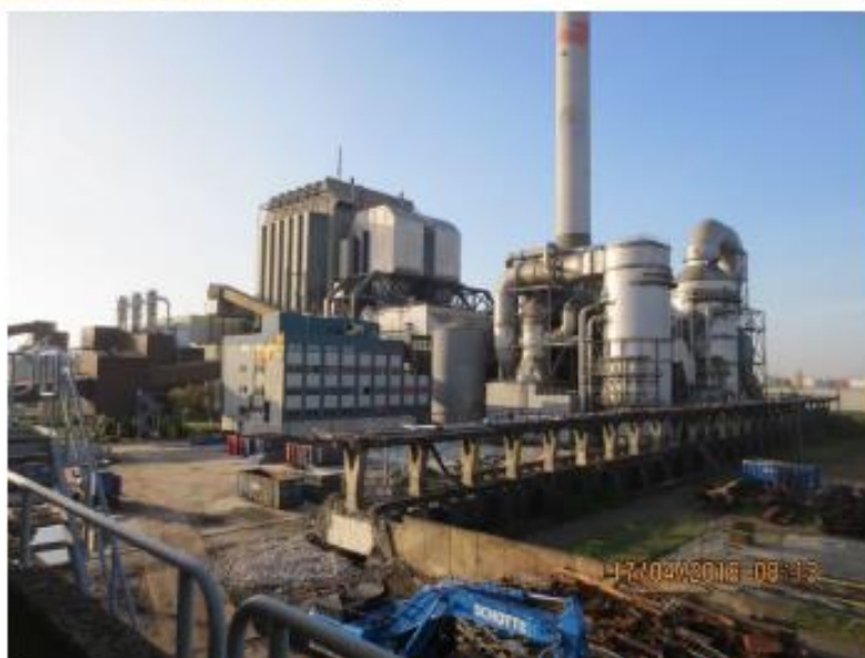
Voortgang sloopwerkzaamheden vanuit zuid kant terrein
