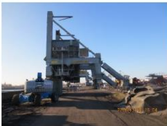
Foto 1 : Voortgang sloop kolenloskranen
