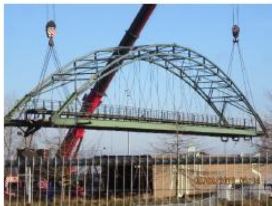
Foto 2 : Hijswerkzaamheden loop- en leidingenbrug
