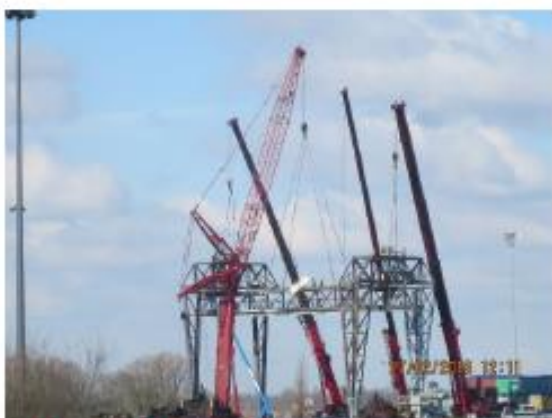
Foto 3 : Ontmanteling containerkraan BCTN
